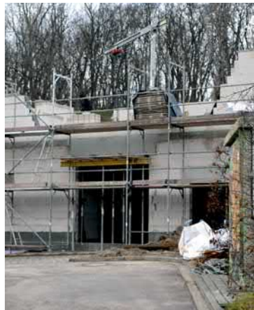
Das im Bau befindliche Blockheizkraftwerk
